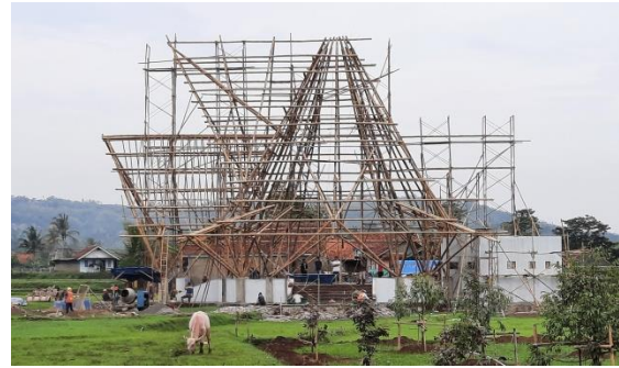
Gambar 4. Pembangunan Bamboo Creative Center di Selaawi, Kab. Garut (Sumber: dokumentasi peneliti)
